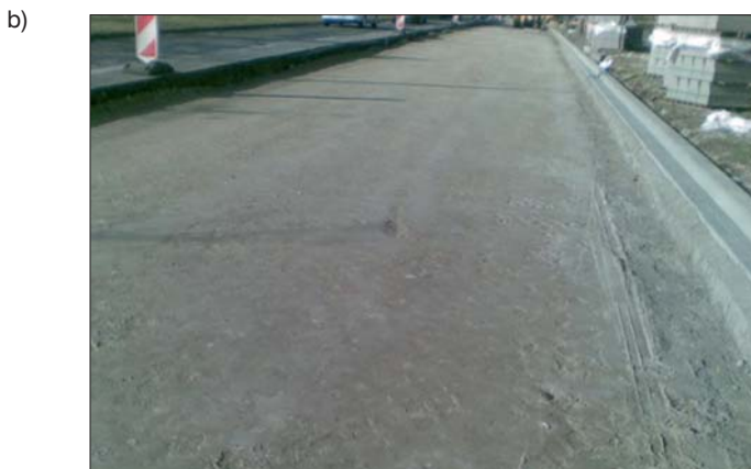
Fot. 1. Odcinek drogi w okresie budowy a) widok podłoża (Gp), b) widok zawałowanego kruszywa łamanego uszczelnionego miatłem
